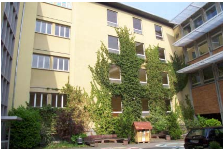
Fassade des Gebäudes Seminarstraße (Schulhof)
