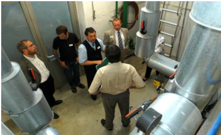
Öko-Audit: Besichtigung der Fernwärmanlage im Schulhaus. Fernwärme ist ein Abfallprodukt der Stromerzeugung im Rheinhafen-Dampfkraftwerk
