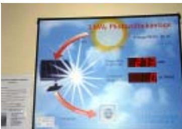
Ein Display im Eingangsbereich zeigt die momentane Leistung und den gewonnenen Energiebetrag an.
